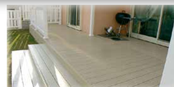
基礎まで全て樹脂の腐らないバイナルデッキ
